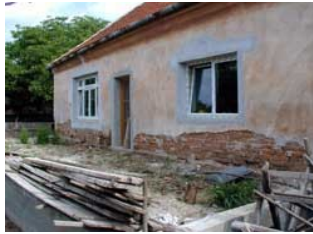
Hier soll eine Terrasse entstehen ...
